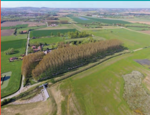
VUE AÉRIENNE DE LA ZONE D’EXPANSION DES CRUES N°4 ( 35ha ) ET DE L’OUVRAGE HYDRAULIQUE N°2
